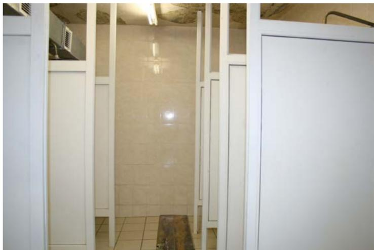
Отслаивание и шелушение отделочного покрытия потолков душевых помещений является следствием повышенной влажности в результате недостаточной вентиляции (особенно в зимнее время) в помещениях. По всем душевым уже разработаны графики включения вентиляции,
