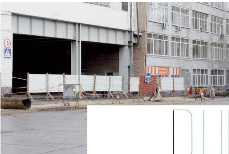
В районе перекрестка рядом с корпусами МСК-1 и МСК-2 силами ООО «Производственная инжиниринговая компания» начато производство земляных работ, связанных с заменой участка трубопровода технической воды. Работы продлятся до 30 октября.
